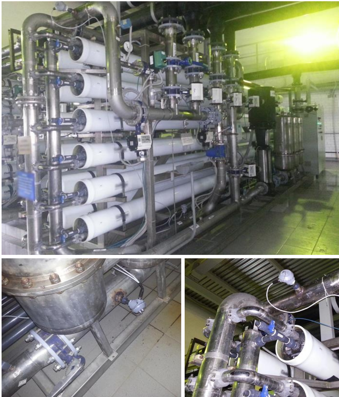
Figura 1: Descripción del sistema de RO (arriba), Sensor ALVIM instalado antes de la RO (abajo, a la izquierda), Sensor ALVIM instalado en la línea del concentrado (abajo, a la derecha)
