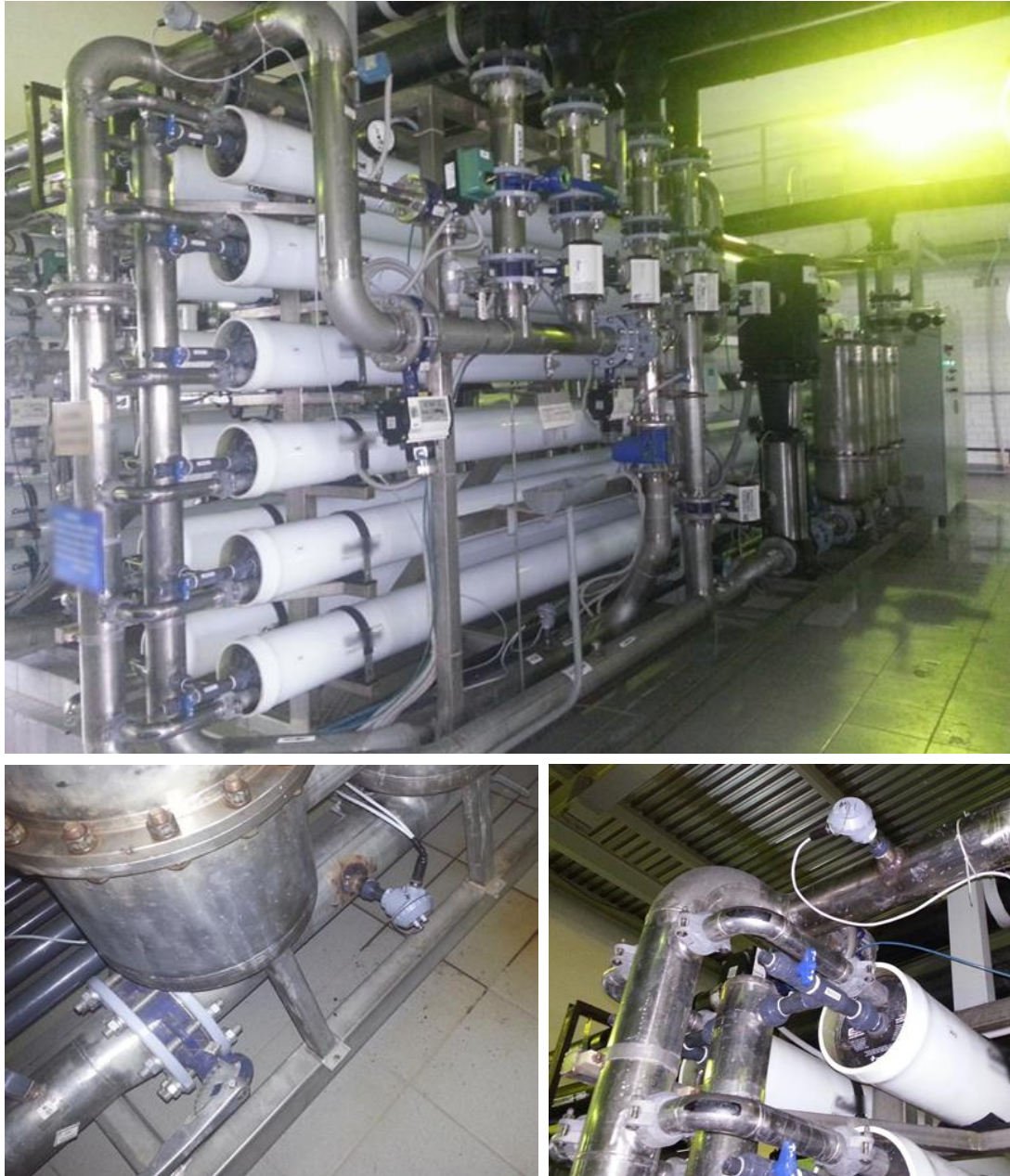
Figura 3: Panoramica del sistema RO (in alto), Sensore ALVIM installato prima della RO (in basso, a sinistra), Sensore ALVIM installato sulla linea del concentrato (in basso, a destra)
